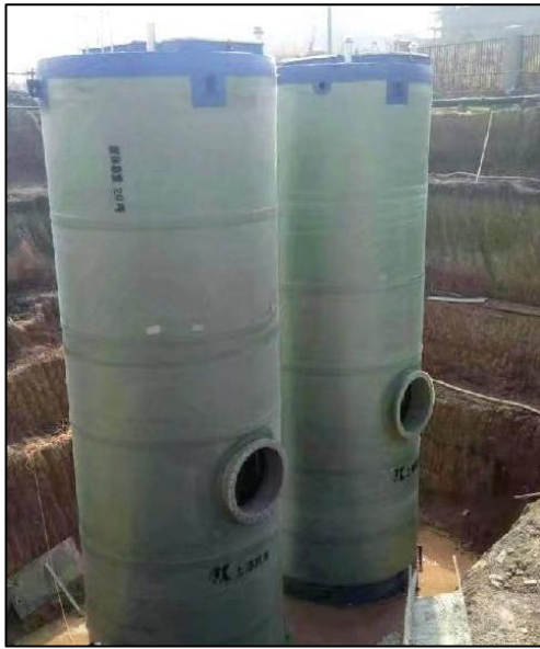
图 2-2 地埋式一体化泵站示意图
