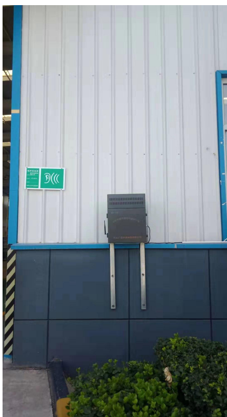
工业漆车间无组织报警装置
